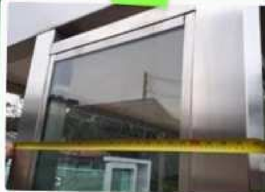
Abrigos de passageiros de ônibus (TCE-MP) CC207/2019
