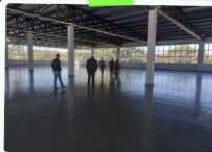
Reforma e ampliação do Pavilhão 6 do Parque de Exposições Dr. Valmor Ernesto Lunardi - EFAPI
