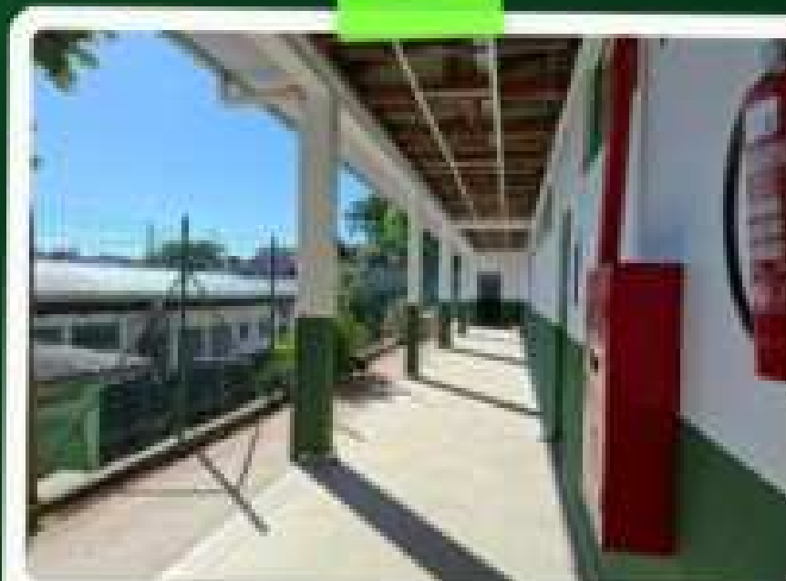
Ampliação e reforma da EBM Herbert de Souza
