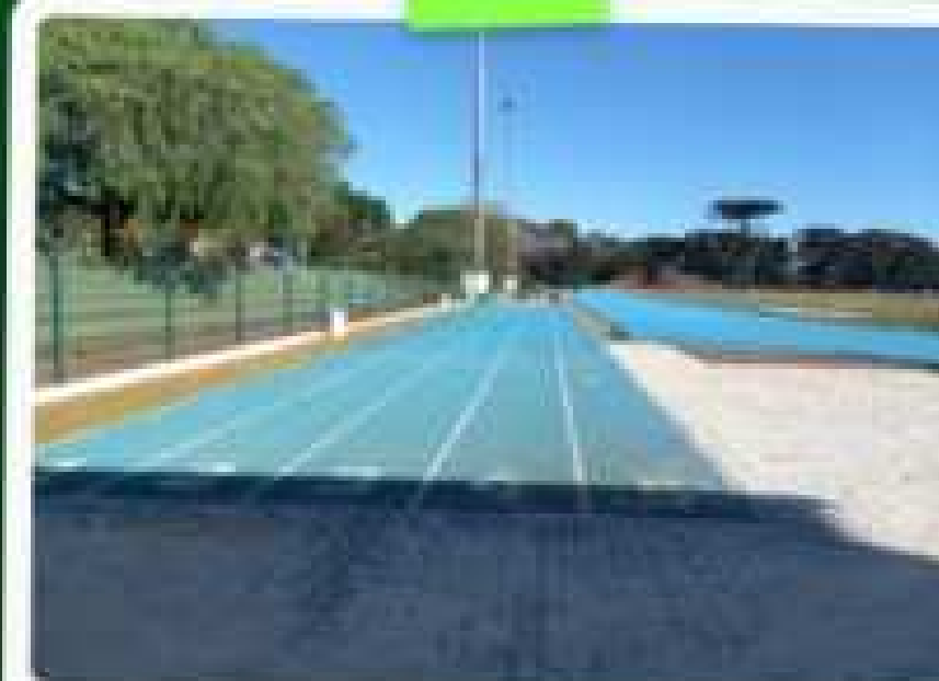
Construção de uma pista de atletismo oficial, classe II (classificação IAAF), no Complexo Esportivo Verdão
