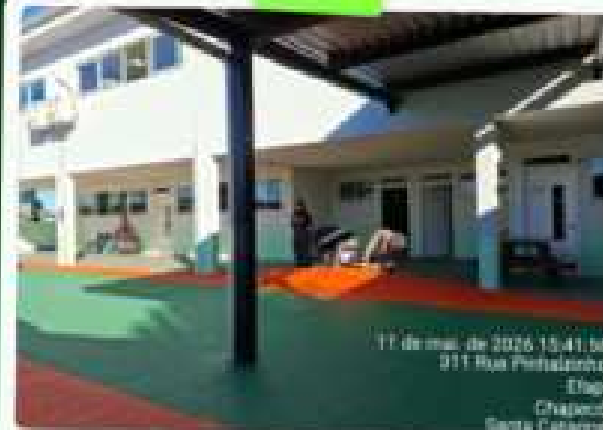
Reforma e cobertura da parte do playground do CEIM Pequenos Heróis
