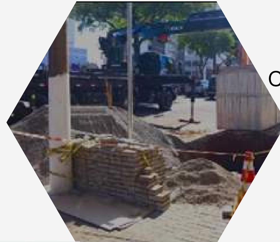
Ampliação e Modernização da Arena Condá - II
