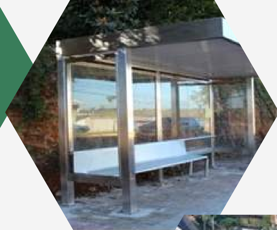
Abrigos de Passageiros de Ônibus Urbanos
